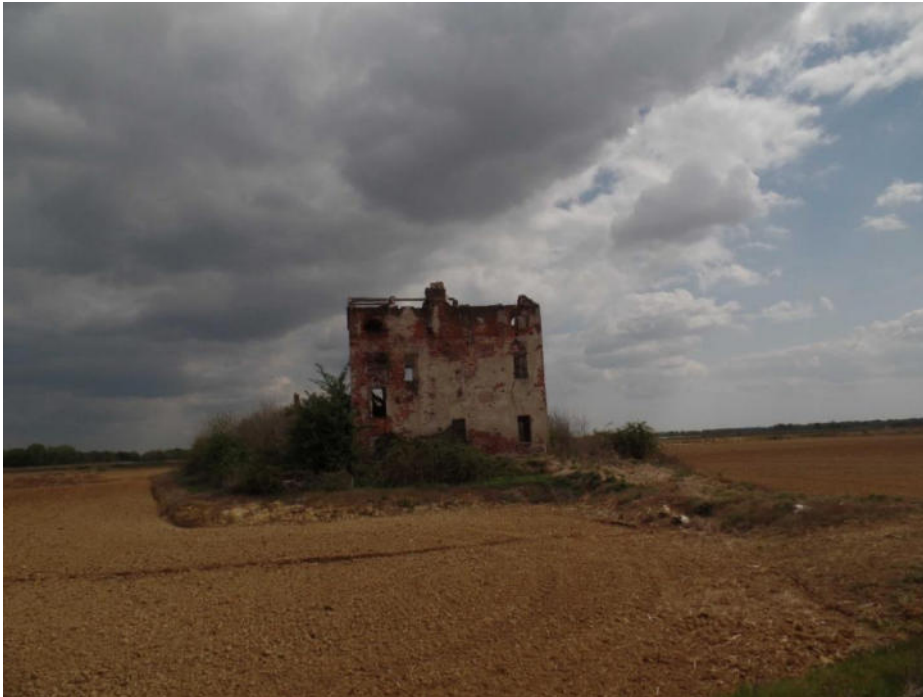
Figura 2.20 - Visuale dell'edificio parzialmente diroccato situato nel settore centro-occidentale dell'area di intervento.
