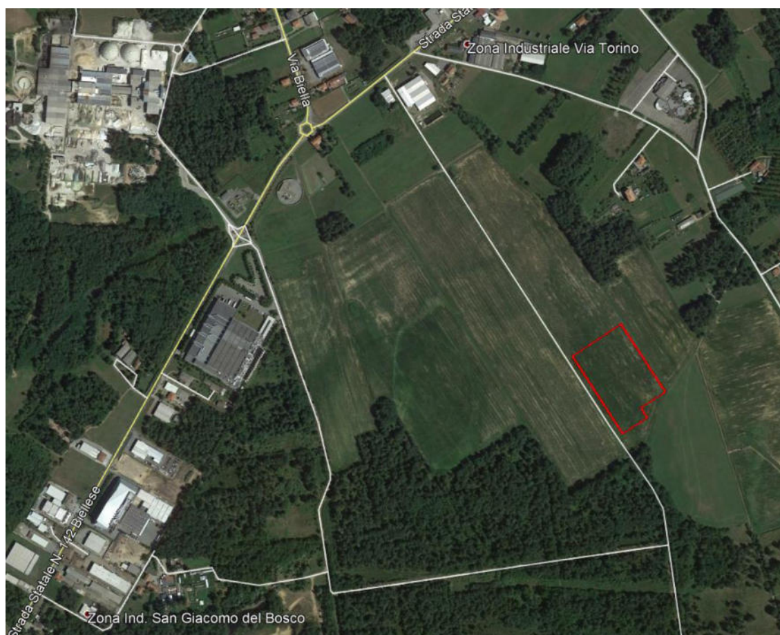
Figura 2.6 - Inquadramento su foto aerea (fonte: Google Earth®, immagine fuori scala).
