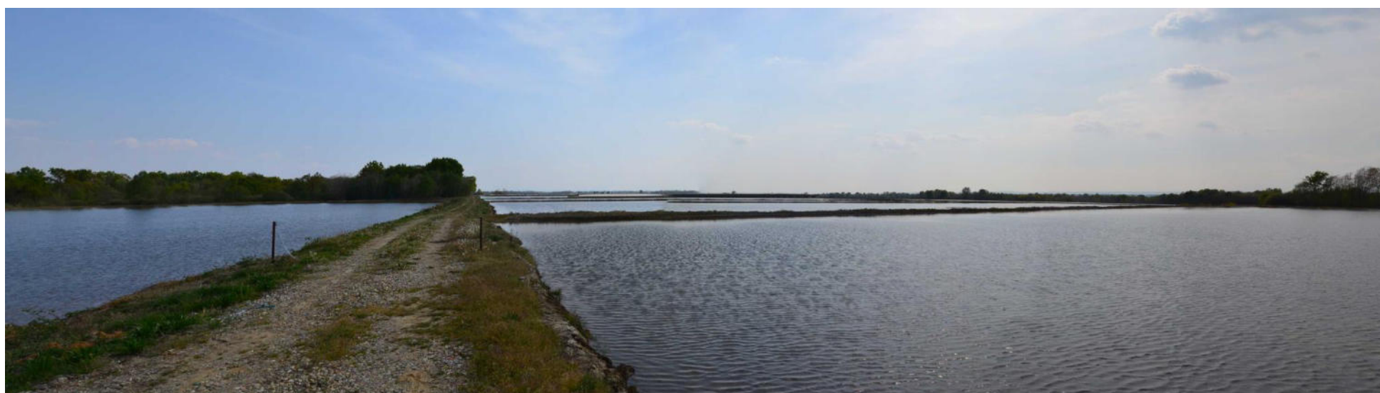
Figura 7.12 - Stato di progetto senza le siepi perimetrali e di connessione ecologica. L'immagine mostra l'area di intervento al termine dell'installazione degli elementi tecnologici per la produzione di energia elettrica rinnovabile. Questi, a causa della significativa distanza, risultano scarsamente visibili.
