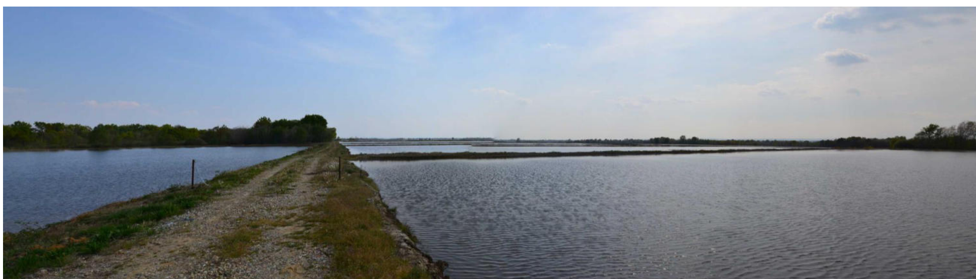
Figura 7.11 – Stato di fatto. Panoramica in direzione sud, dai pressi del tracciato della SP 317 verso l'area di progetto. Questa, posta a circa 550 metri di distanza, risulta scarsamente visibile.
