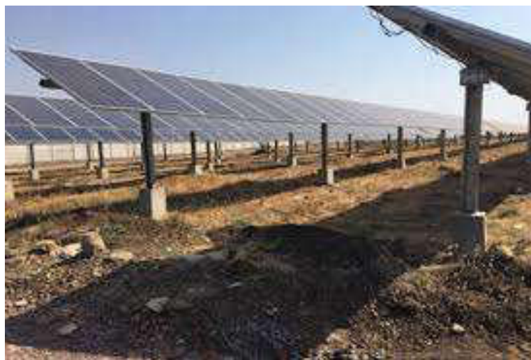
Figura 43: Esempio di impianto fotovoltaico con fondazioni ottenute mediante perforazione del terreno e successiva creazione del palo di fondazione con getto di cemento.
