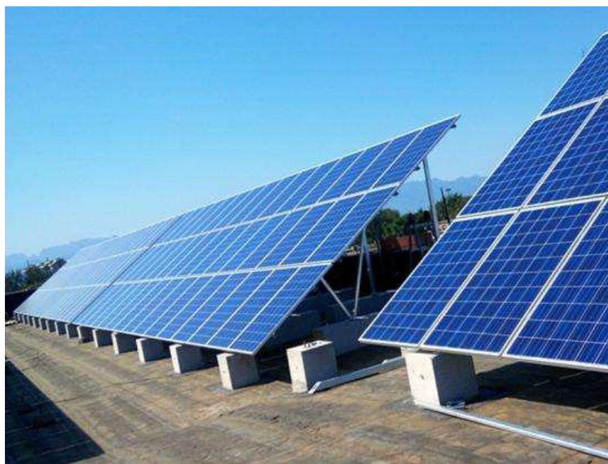
Figura 45: Esempio di impianto fotovoltaico con fondazioni formate da zavorre costituite da plinti in cemento.
