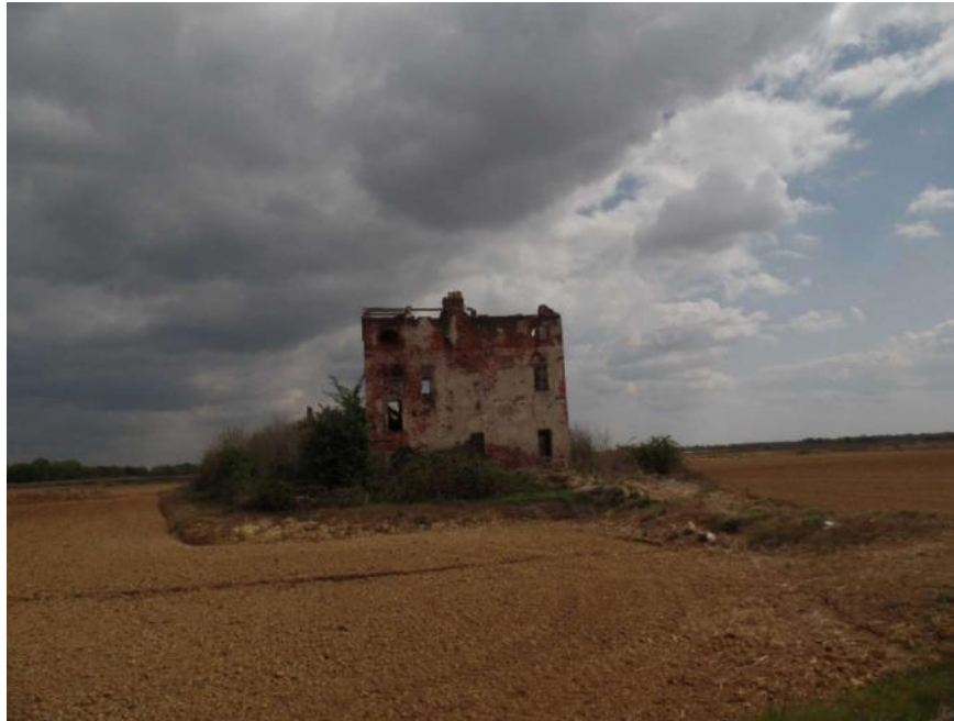
Figura 24: Visuale dell'edificio parzialmente diroccato situato nel settore centro-occidentale dell'area di intervento.
