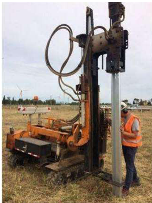
Figura 40: Esempio di supporto costituito da palo in acciaio infisso direttamente nel terreno mediante battipalo.
