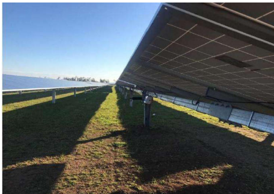
Figura 41: Esempio di impianto fotovoltaico realizzato con supporti costituiti da pali in acciaio infissi direttamente nel terreno. Gli impatti sul suolo sottostante risultano essere minimizzati.
