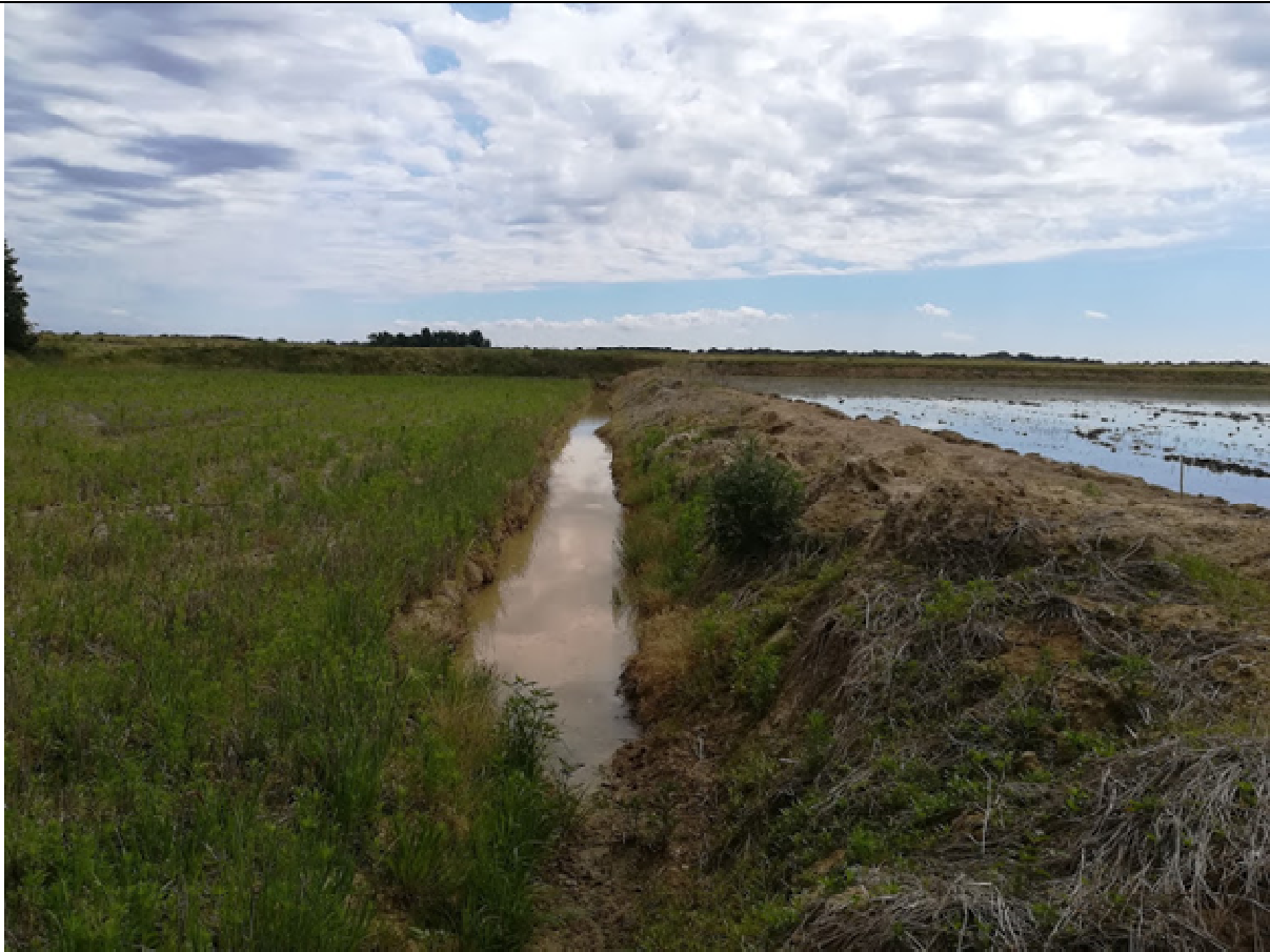
Fig. Fosso colatore vista da ovest
