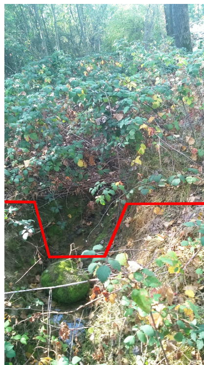
fotografia canale sul tratto A-B
