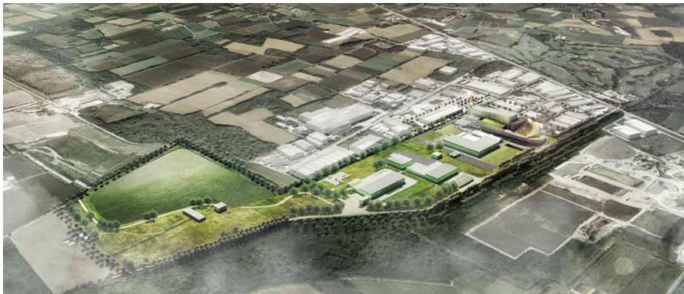
Fig.36: Fotoinserimento Impianto nel Polo tecnologico di Cavaglià_2
