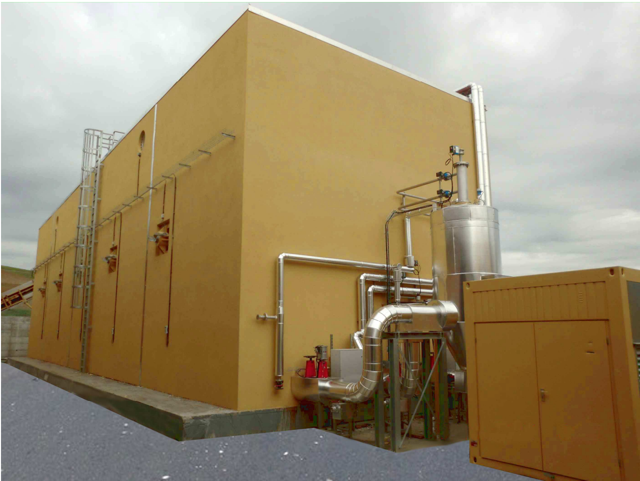
Esempio di digestore plug-flow
