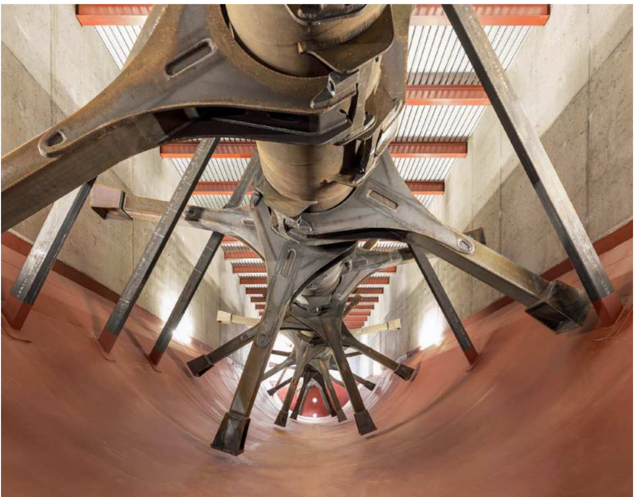
Esempio di digestore con albero longitudinale e pale
