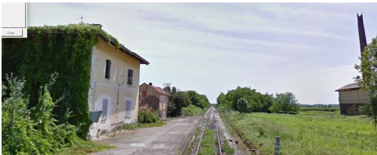
Figura 39 – stato attuale della stazione del Brianco
