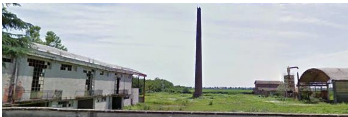
Figura 38 – Stato attuale della Fornace
