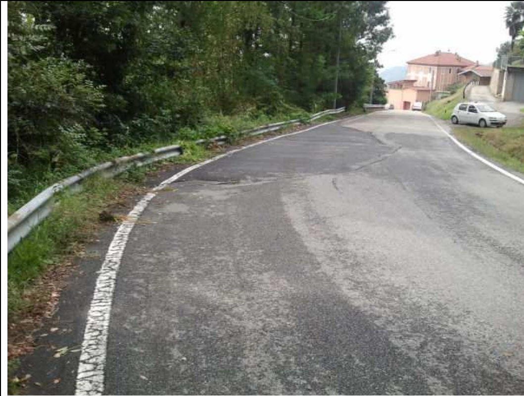
Foto 4 immagine intervento n. 2 lato monte SP 103, di ripristino cedimento stradale.
