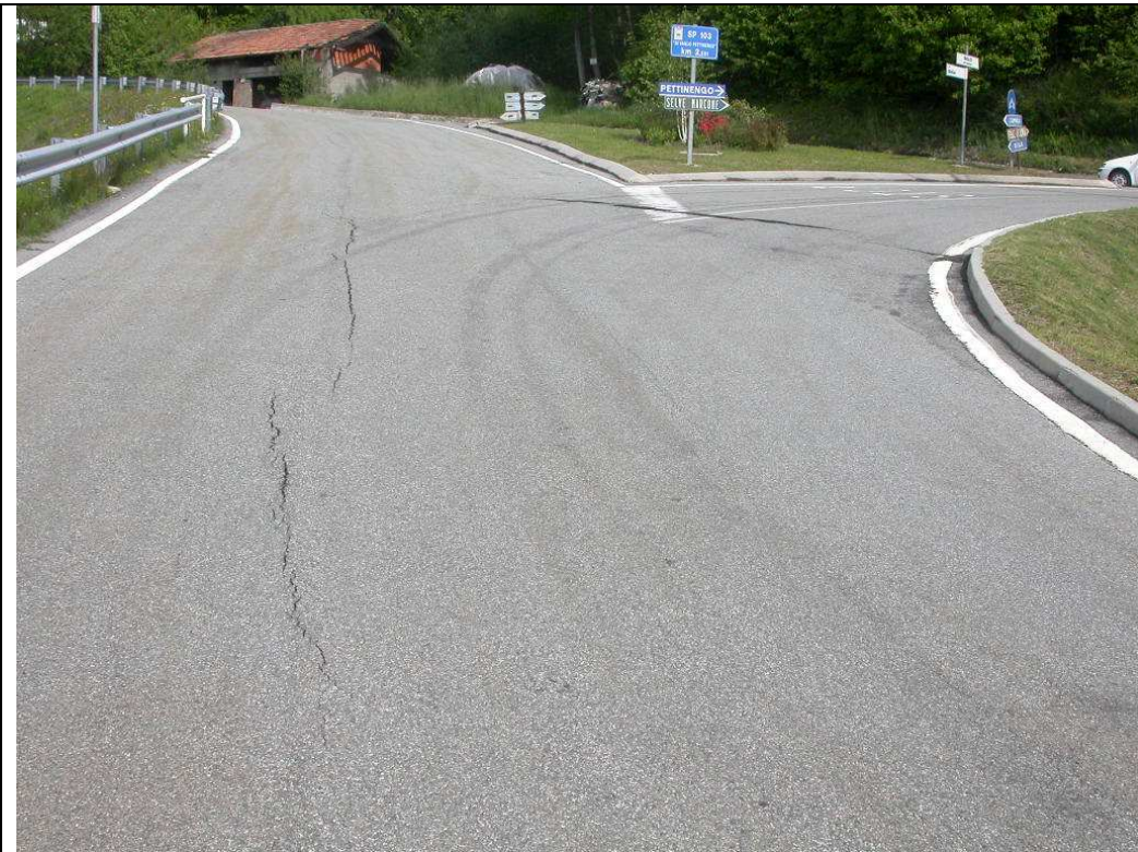
Foto 1 immagine area incrocio oggetto di cedimento tra la SP 103 e la SP 102
