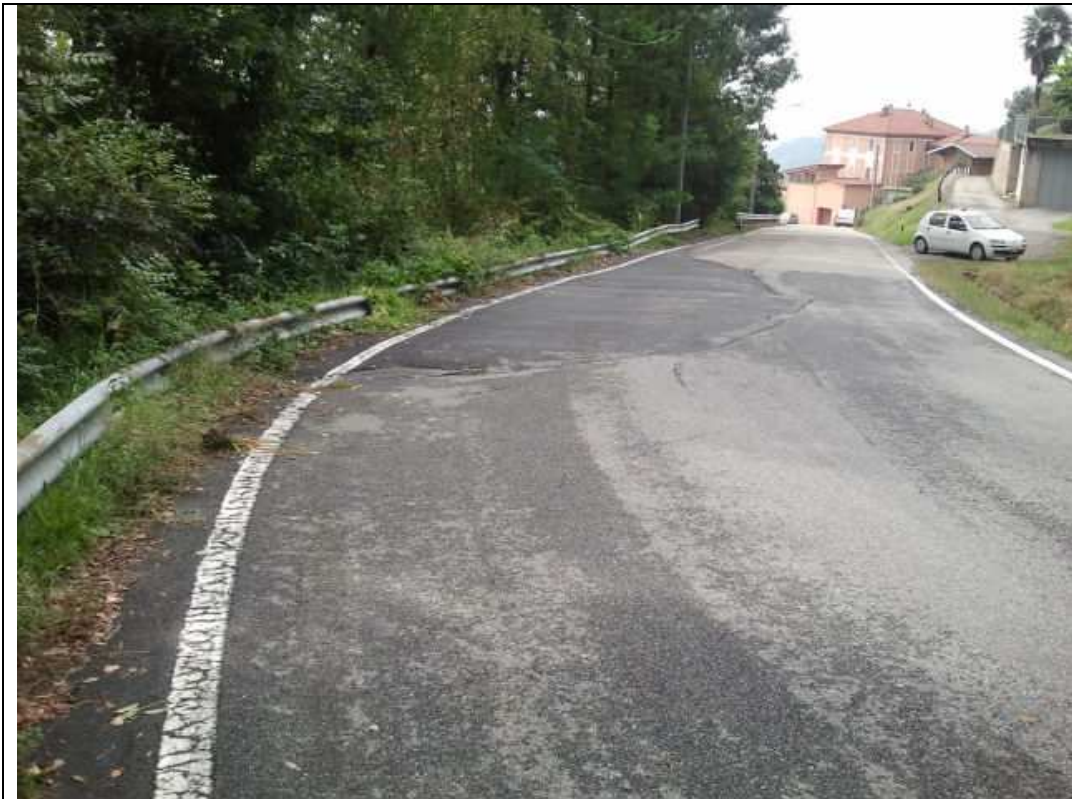
Foto 4 immagine intervento n. 2 lato monte SP 207, di ripristino cedimento stradale.
